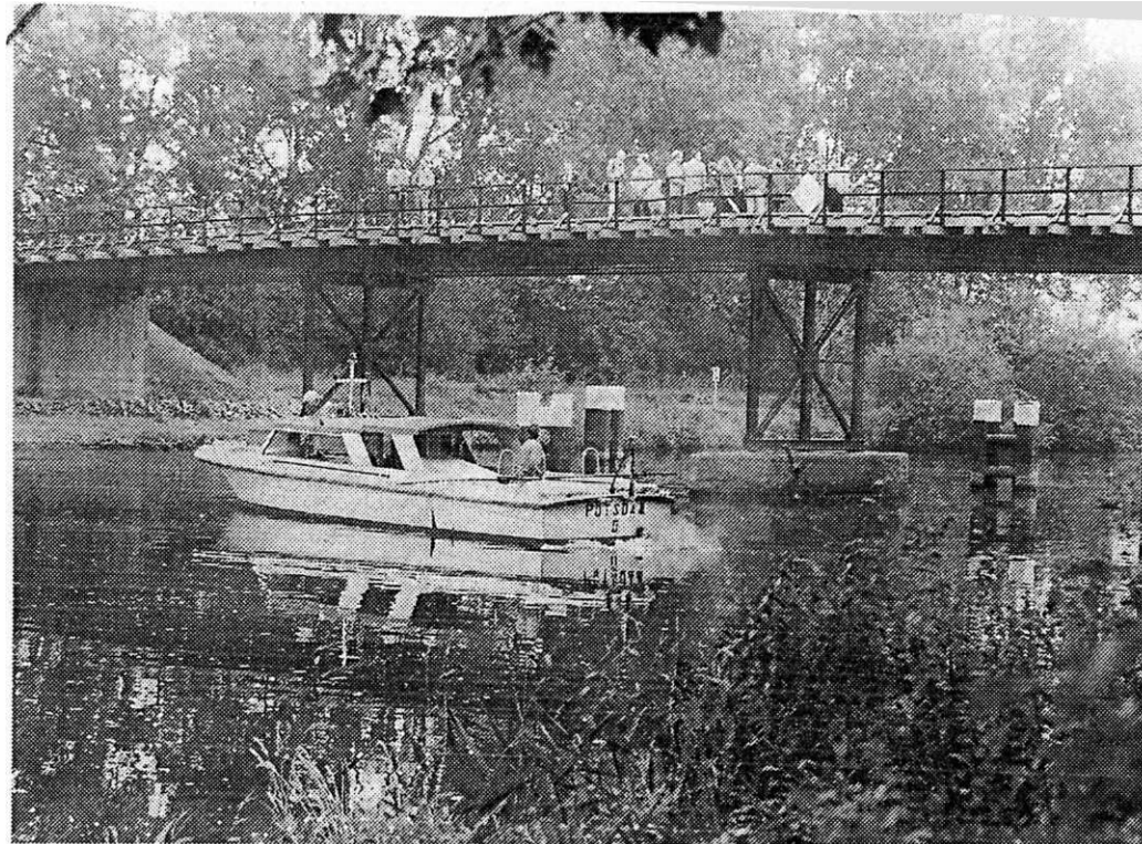
Als erste provisorische Verkehrsverbindung für das Güterverteilzentrum Wustermark ist gestern die den Weg zur Baustelle verbindende Kuhdammbrücke übergeben worden. Mit dicken Holzbohlen belegt kann sie nunmehr auch von schweren Baufahrzeugen passiert werden. Die Baukosten beliefen sich auf 1,5 Millionen Mark, wovon seitens der Landesregierung 126 000 Mark beigesteuert wurden. Foto: Radon
